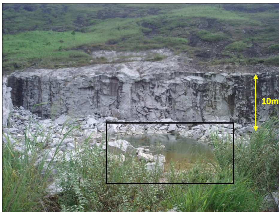
Figura 4.25: Pedreira desativada vista da PE-103 (Destaque - em preto - para o acúmulo de água oriunda de um aquífero fissural).
