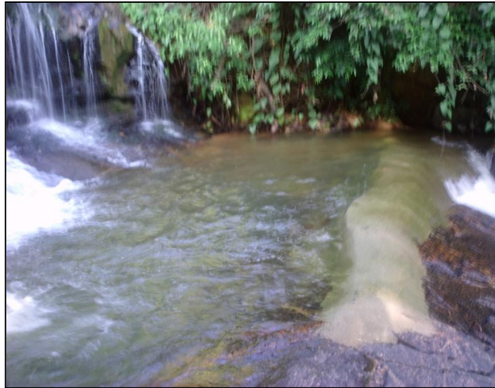
Figura 4.15: Piscina artificial formada pela construção de uma barragem de cimento sobre a rocha.
